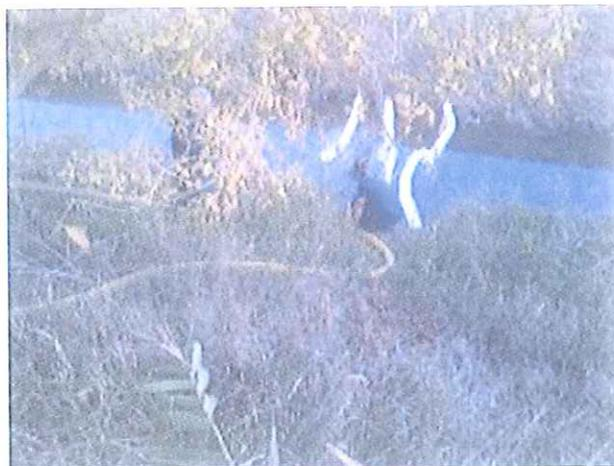
Foto 7: Particolare posizionamento barriere oleoassorbenti
